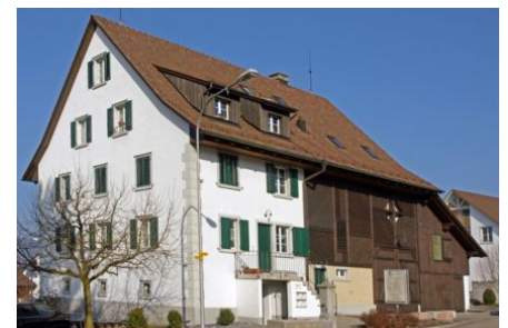
Der Neubau musste äusserlich möglichst genau dem abgerissenen Haus entsprechen
