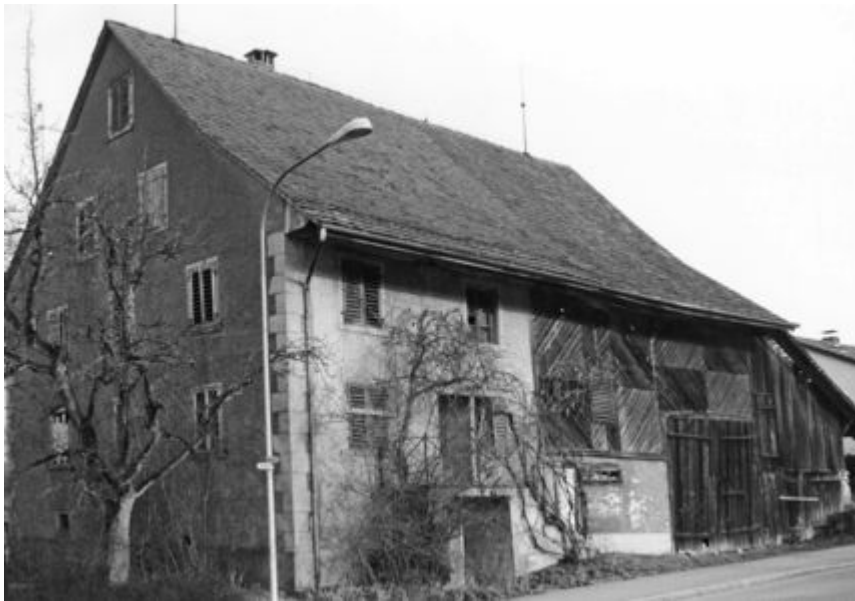
Das Haus von Anna Stüssi kurz vor dem Abbruch
